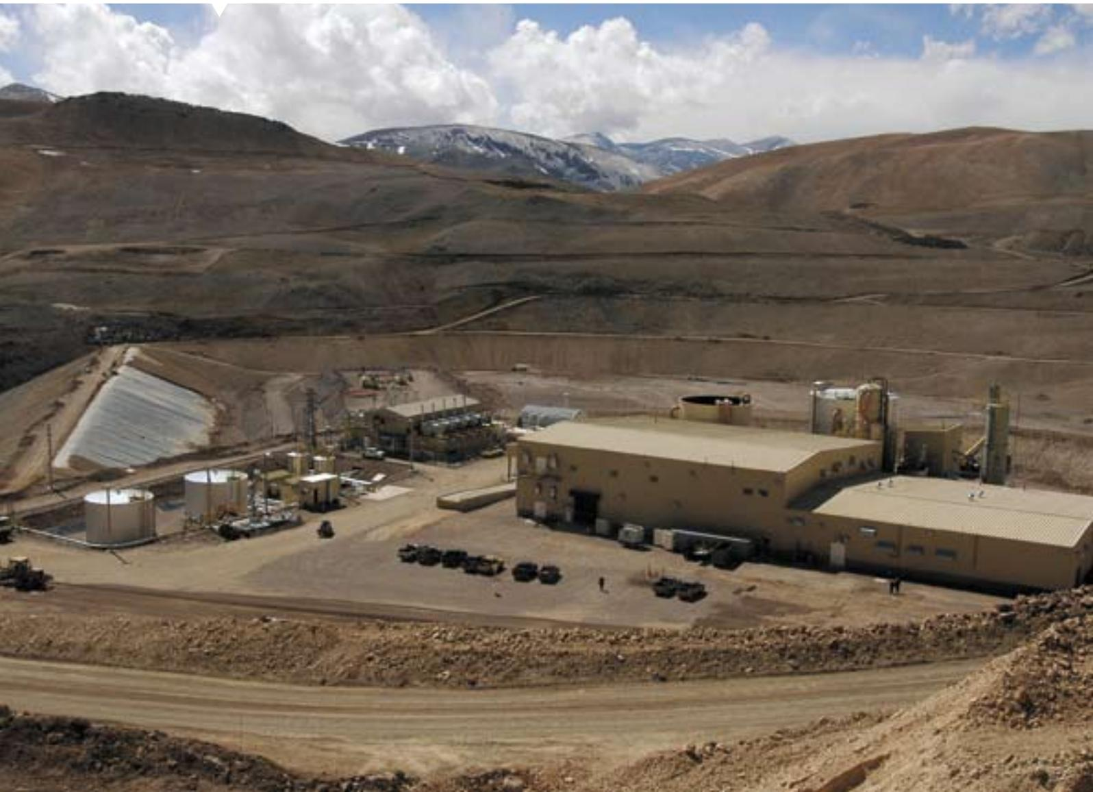
Los camiones cargan las piedras procesadas y las depositan en el valle de lixiviación. La última etapa se realiza en la planta de proceso, uno de los edificios más complejos realizados por Techint por el equipamiento que incluye. Allí se filtra la solución que proviene de la lixiviación, se reduce y por último se funde en los hornos eléctricos para colar el producto final en moldes para conformar luego los lingotes.
